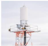
ANTENNES TELECOM & SITES ISOLÉS
